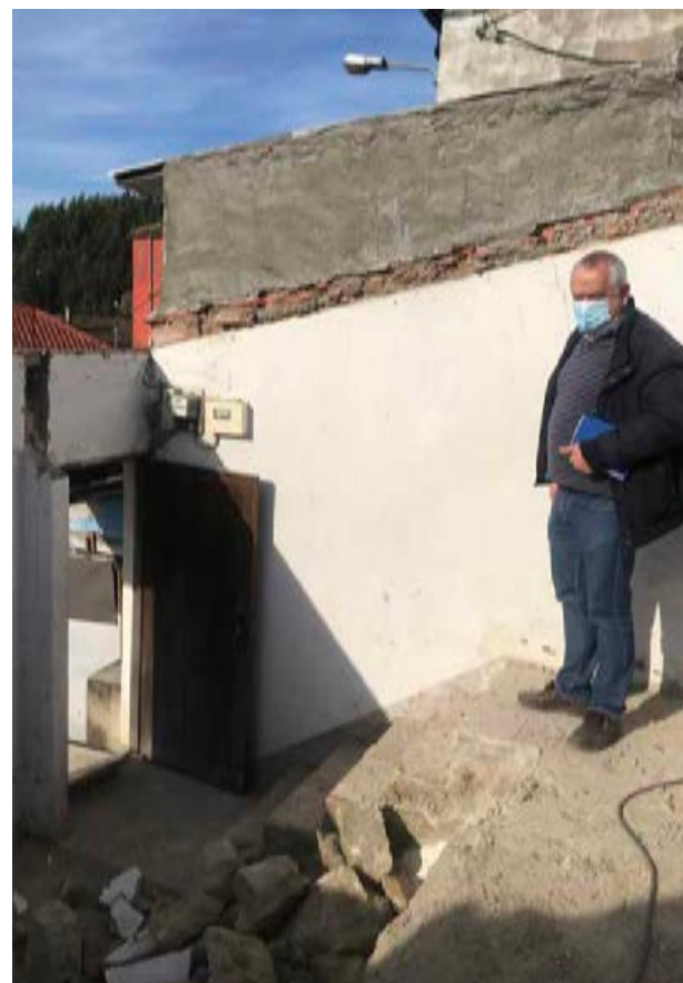
Obras de reparação da habitação (Portugal).
